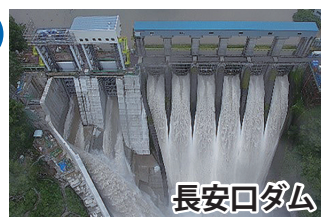
洪水吐ゲート2号(左側)の増設が完了、事前放流も実施される
